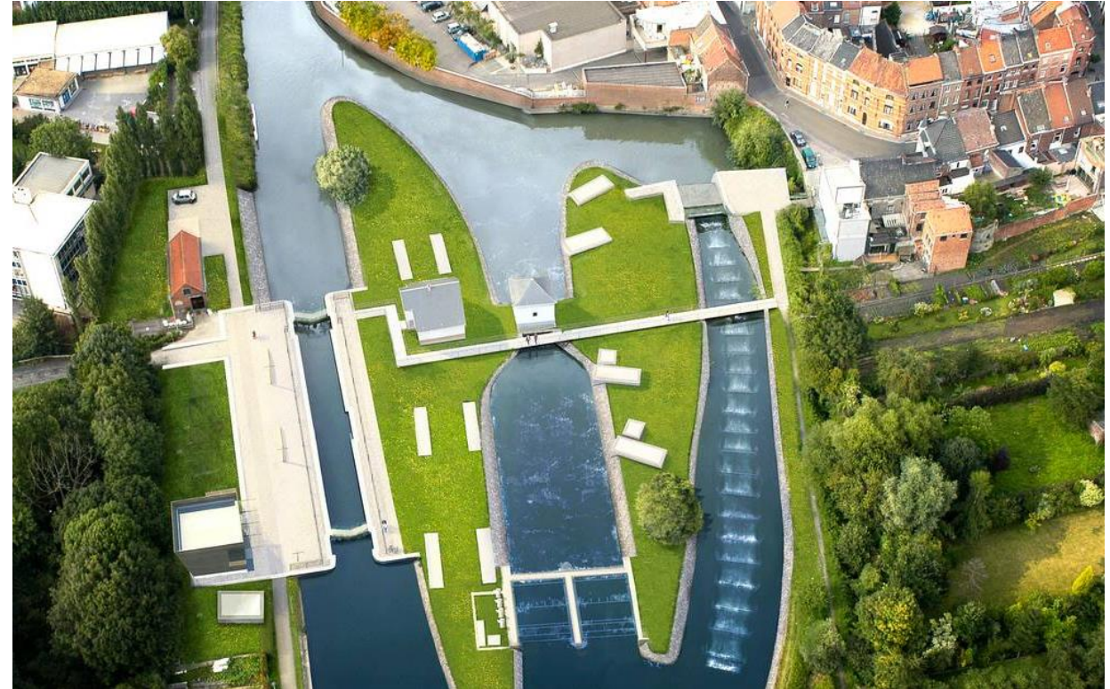
Stuwsluis vernieuwing Geraardsbergen
